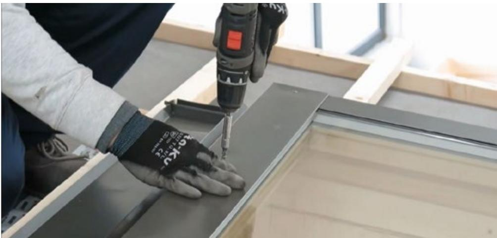
**6** Avvitare il carter superiore sopra la testata usando i fori già esistenti. Fare attenzione che il deviatore di flusso indicato dalla freccia nell'immagine di fase 5, rimanga esterno.
