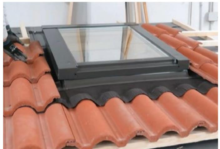
**8** Le tegole vanno disposte sotto il fondo, nella parte bassa della finestra. Vanno disposte invece sopra la testata e i raccordi laterali.
